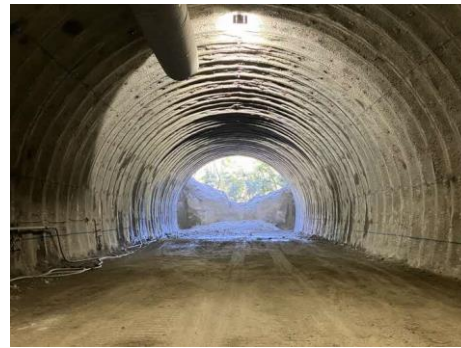
第三南巨摩トンネル 本坑・品川方貫通
