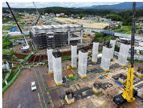
岐阜県駅 (仮称) 高架橋工
