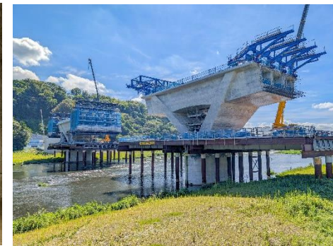
相模川橋りょう 上部工
