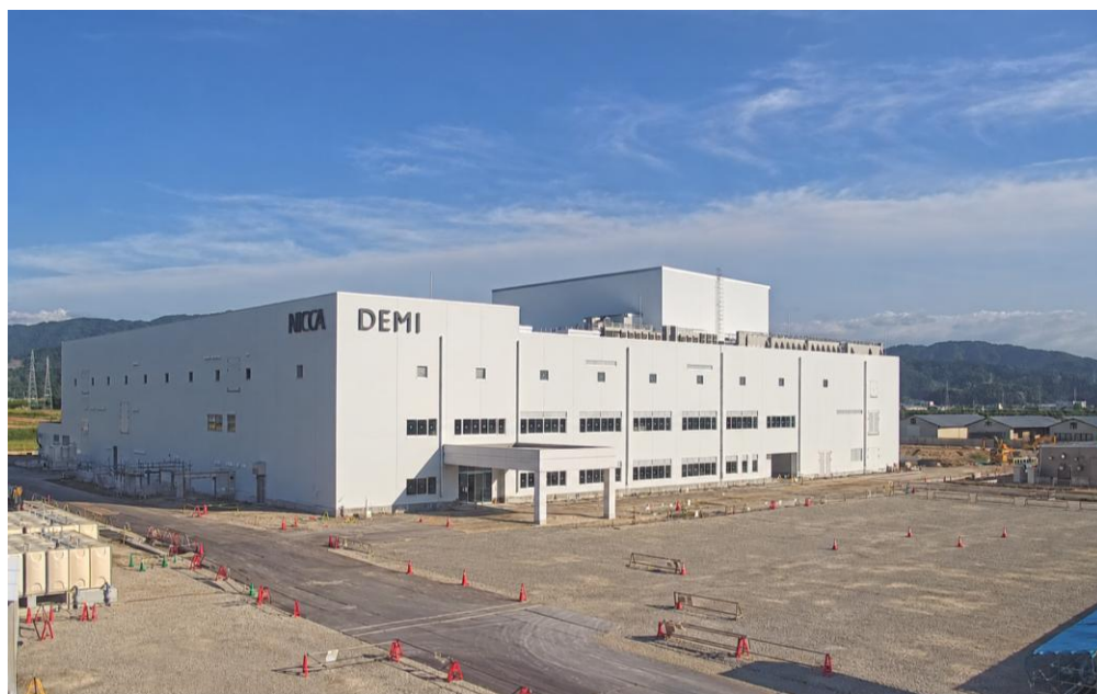
建設工事の様子(9月時点)
