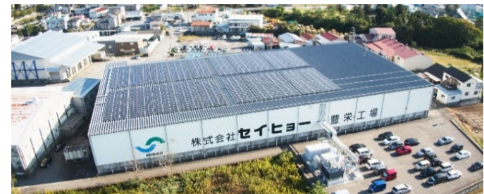
豊栄工場太陽光発電システム（PPAモデル）
