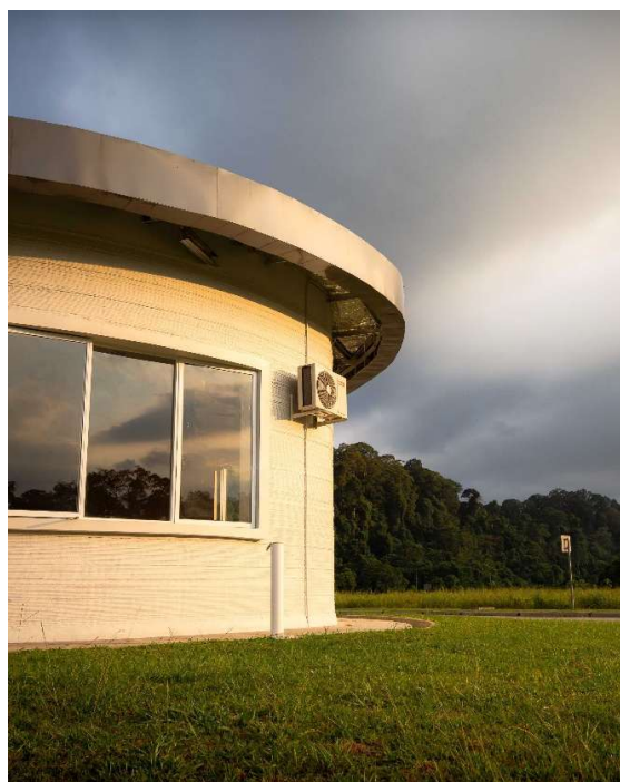
3D プリンティングによる壁面
