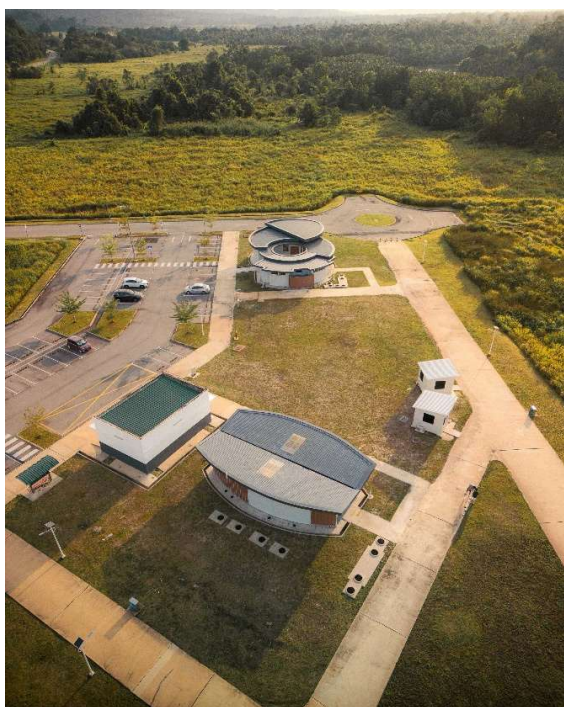
完工後の全景
