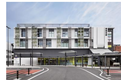
【西日本沿線】プリコ西明石南館開業 (新改札口・駅前広場なども供用開始)
