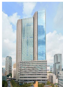
赤坂インターシティAIR 2017年竣工
