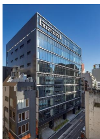
BIZCORE神保町 2017年竣工
