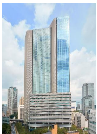
赤坂インターシティAIR 2017年竣工
