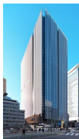
虎ノ門アルセアタワー 2025年竣工
