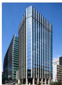
日鉄日本橋ビル 2019年竣工
