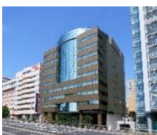
プライム 新横浜ビル
