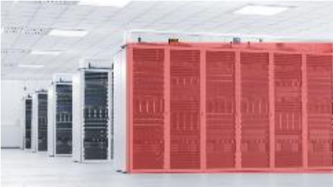
データセンターでの侵入検知例
