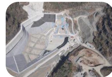
奥山の杜CC（最終処分場）
