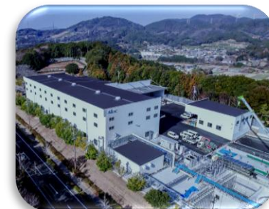
2026年6月 稼働開始 水処理施設 (都田テクノプラント)
