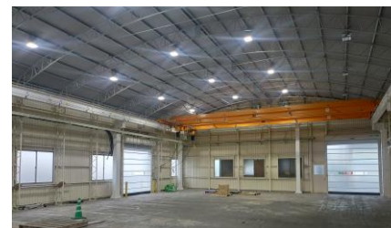
新設備導入のための工場内整備完了
