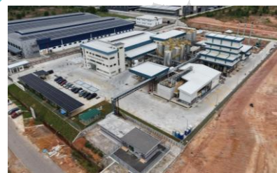
↑ 建設中のマレーシア工場
