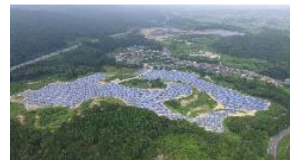
S-01 高萩太陽光発電所
