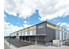
LOGITRES古賀市玄望園 (福岡県古賀市)
