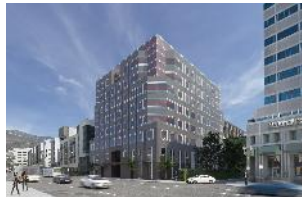
Tower 520 N. Central
