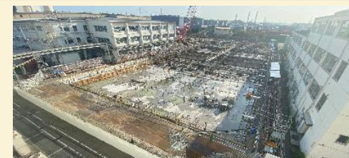
2026年4月の状況:鉄筋の組立工程
