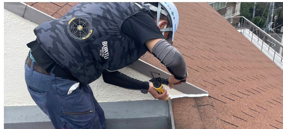
▲シーリング工事
