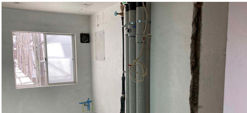
▲給排水管更新
