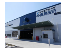
鹿島技研新本社工場
