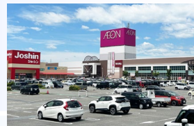
黒崎播磨が売却した底地（建物用途：商業施設）
